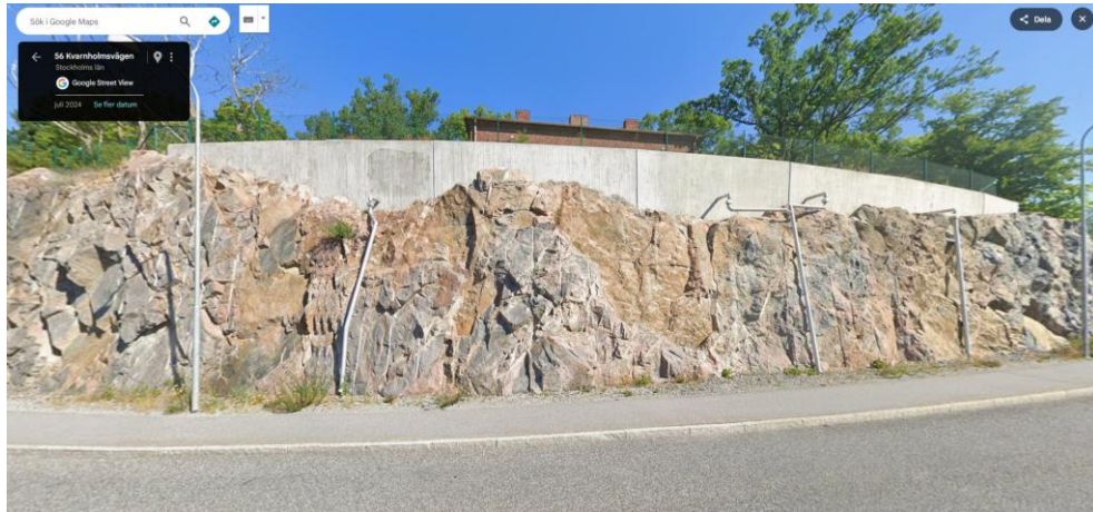
Figur 7: En stödmur belägen söder om Förmansbostaden och som byggdes av Nacka kommun omkring 2014-15 i samband med breddning av Kvarnholmsvägen. Hämtat från Google Maps 2026-01-08.
